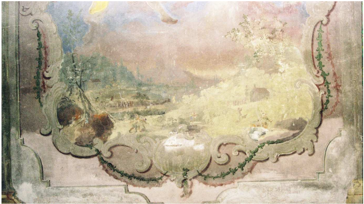
Fot.3-4. Ściana północna. Stan przed konserwacją.
