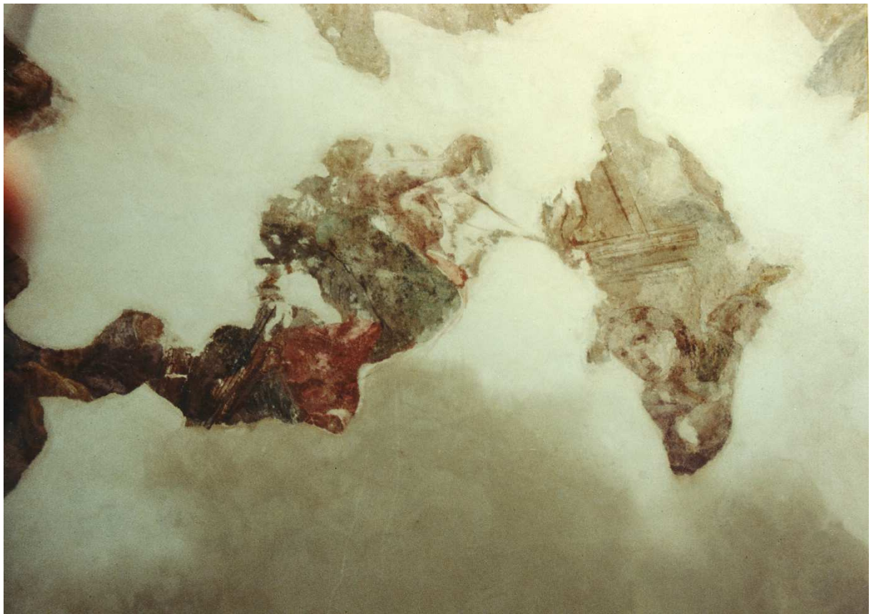
Fot.3-4. Zniszczone partie malowidła. Stan po konserwacji.
